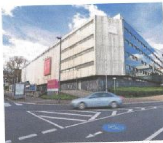
Sanierungsfall Nummer Zwei: Ob die Bonner Oper abgerissen oder instandgesetzt wird, ist auch nach zehn Jahren Diskussion weiter offen.
